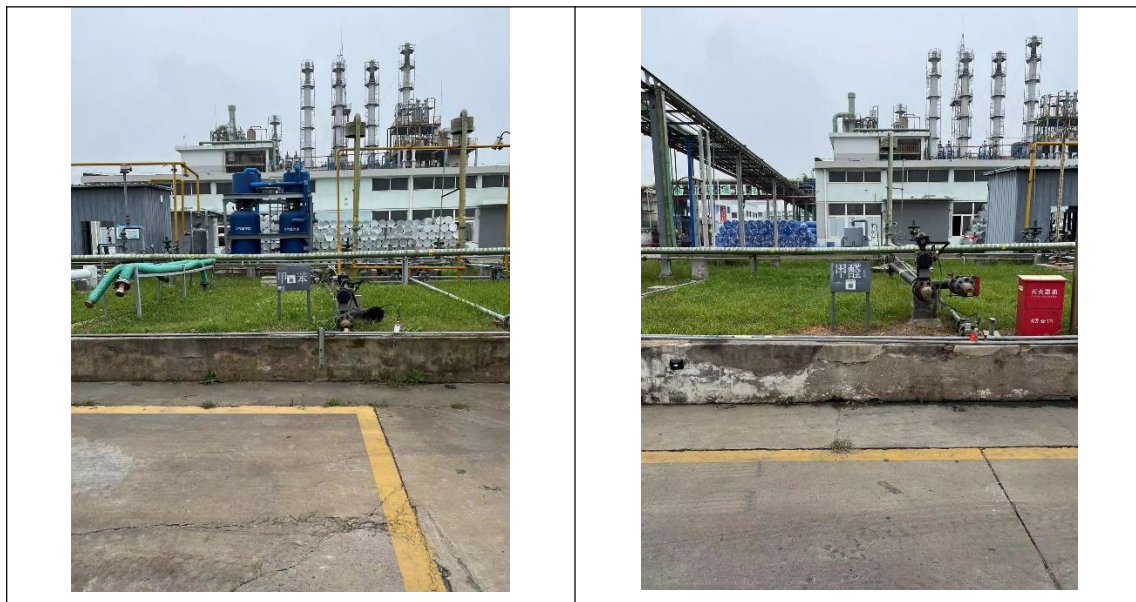
图 4.1-1 地埋式储罐现场排查照片
