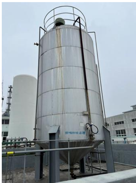
图 4.1-3 离地储罐（频哪酮储罐）现场排查照片
