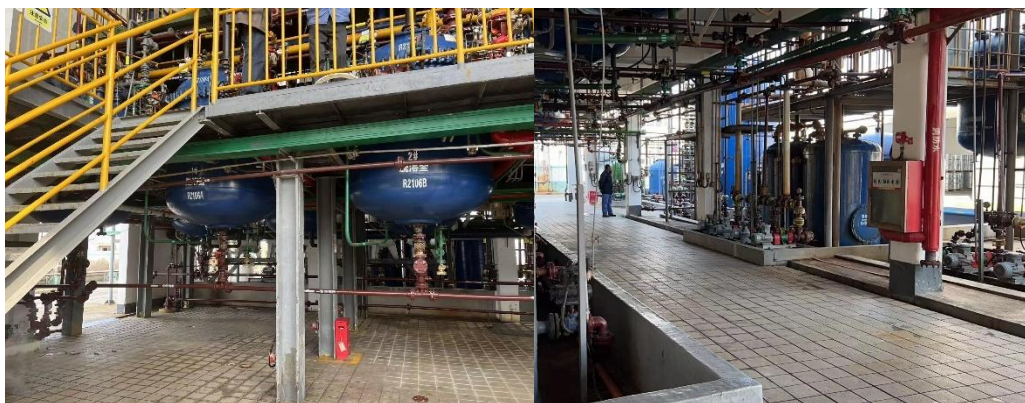
图 4.1-11 生产车间现场排查照片
