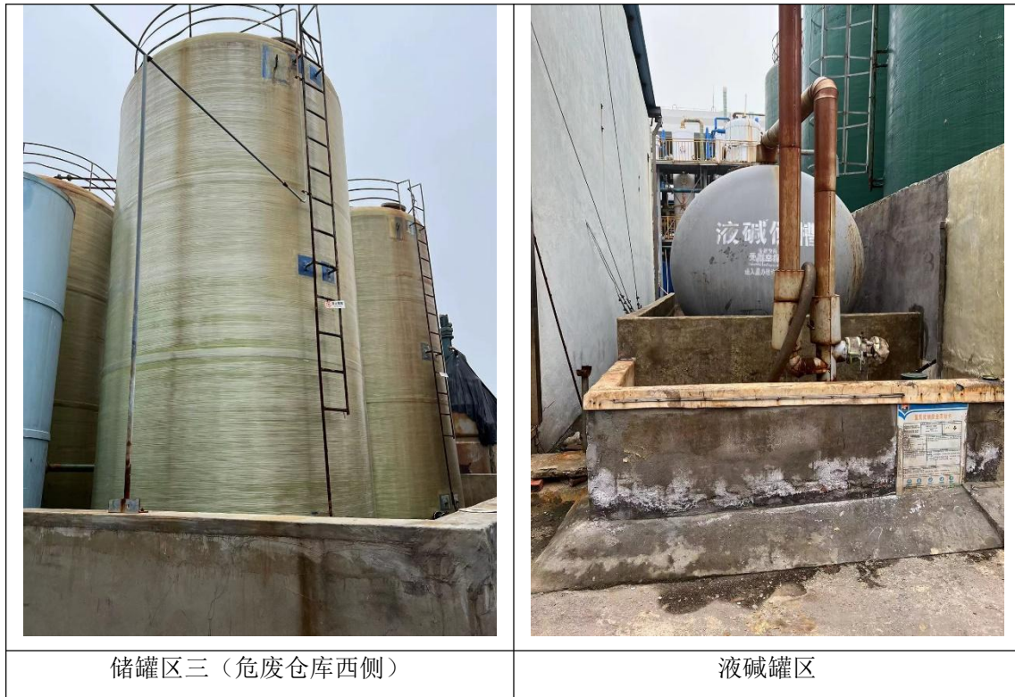
图 4.1-2 接地储罐现场排查照片
