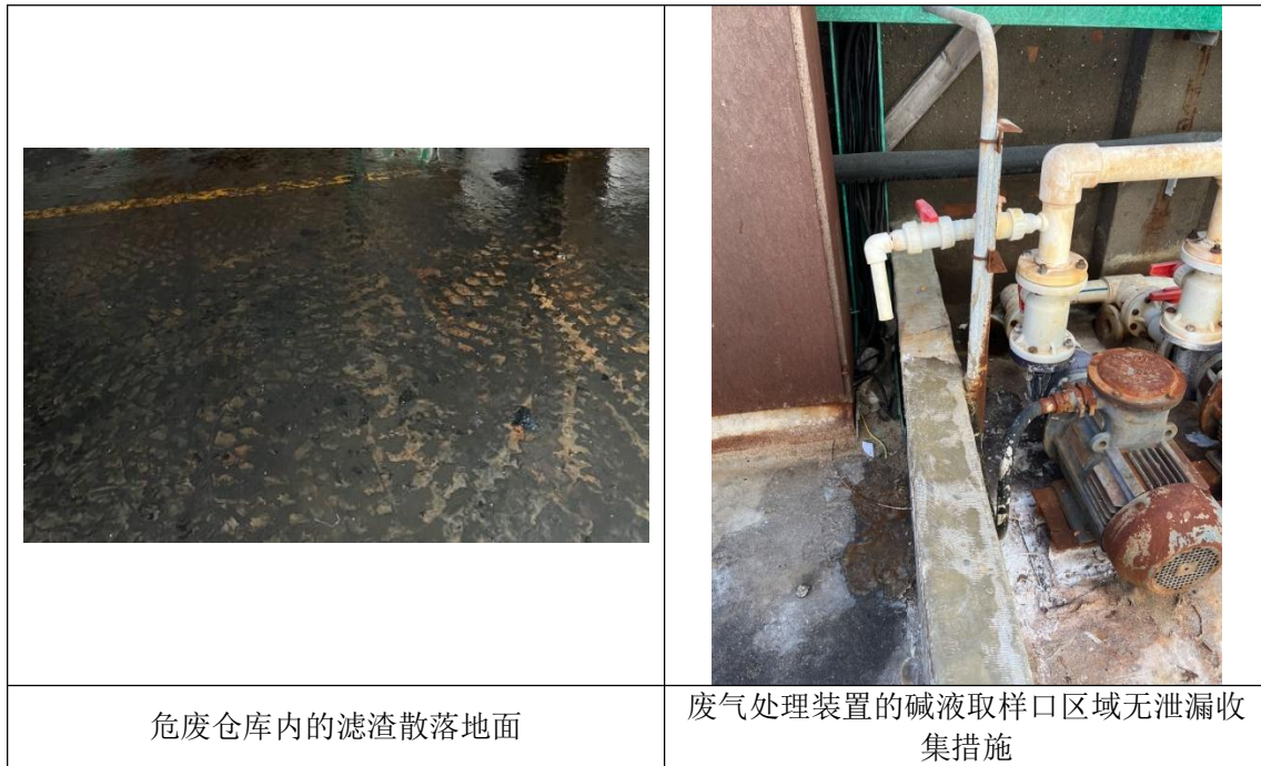
图 4.1-14 危废仓库现场排查照片
