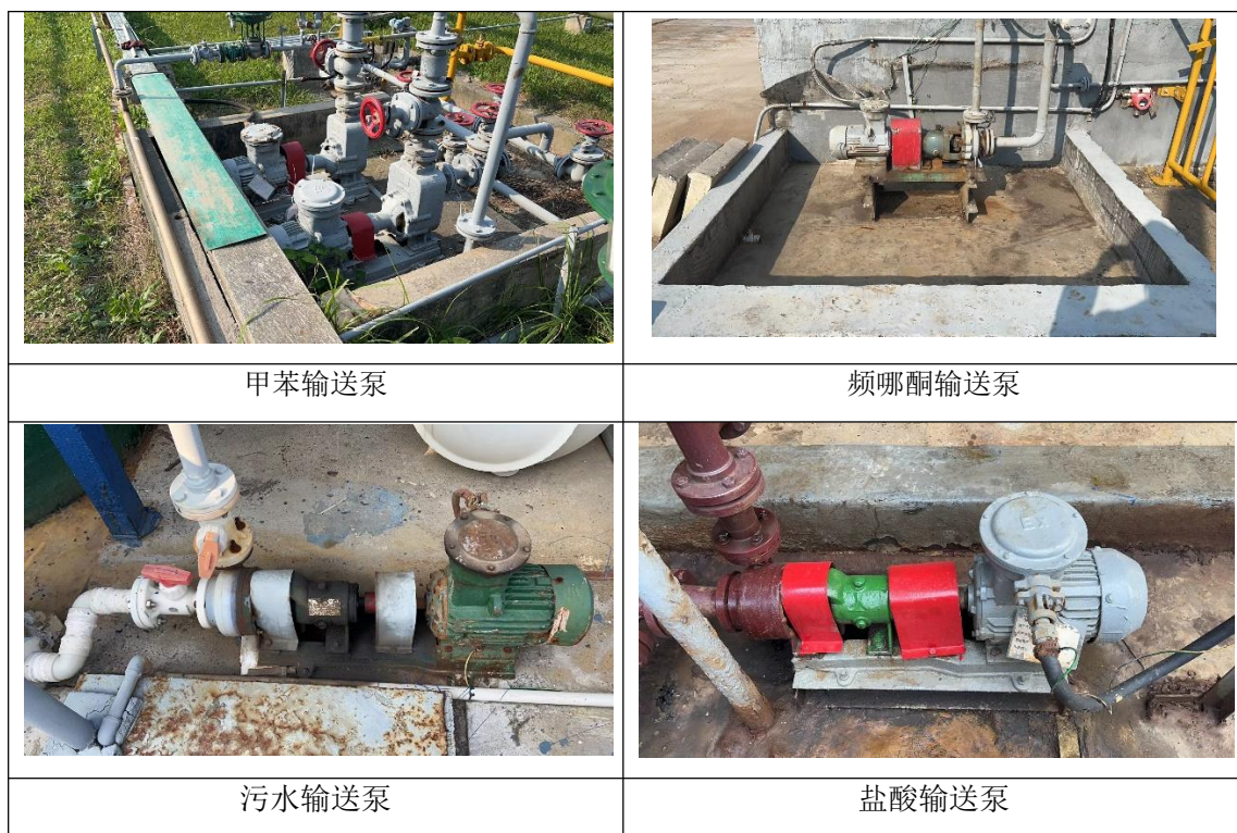
图 4.1-6 传输泵现场排查照片
