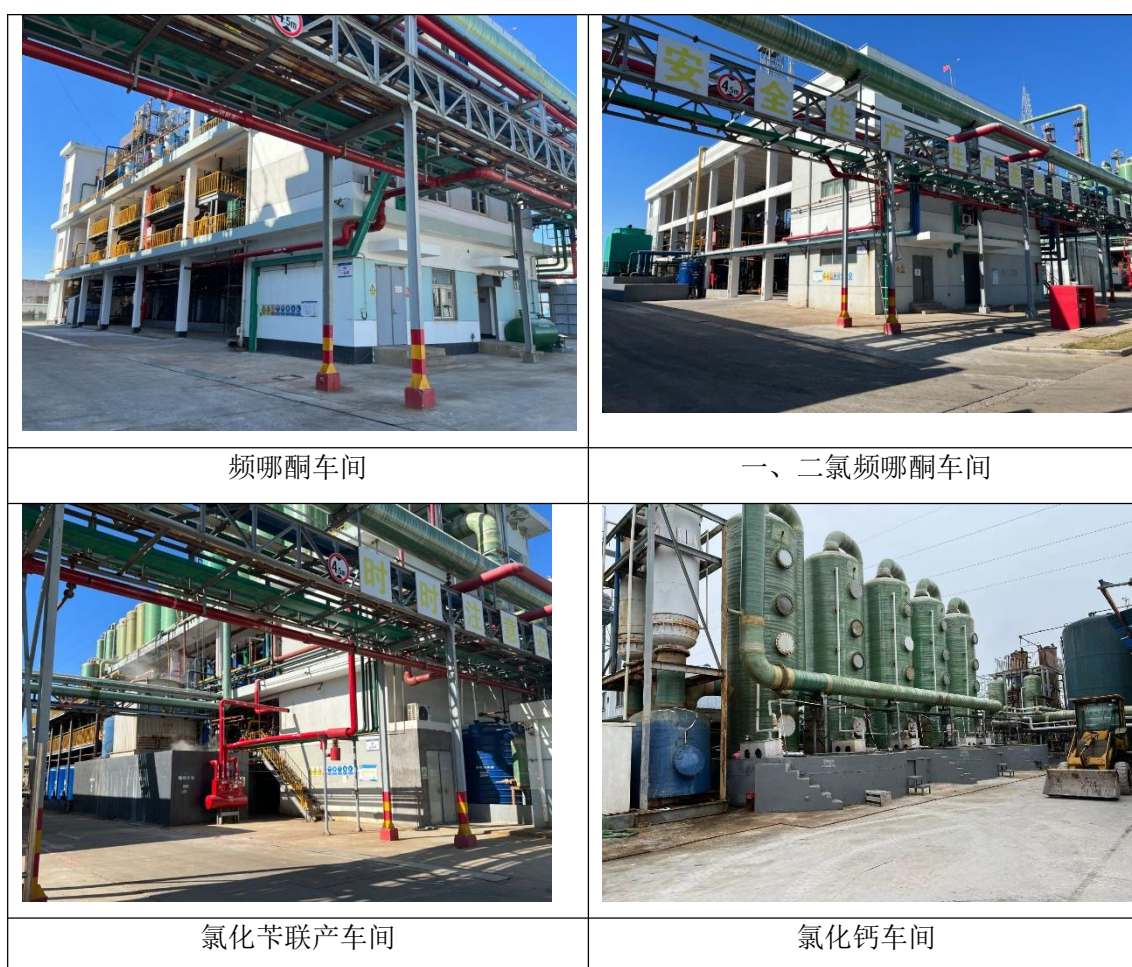
图 4.1-8 生产区现场排查照片
