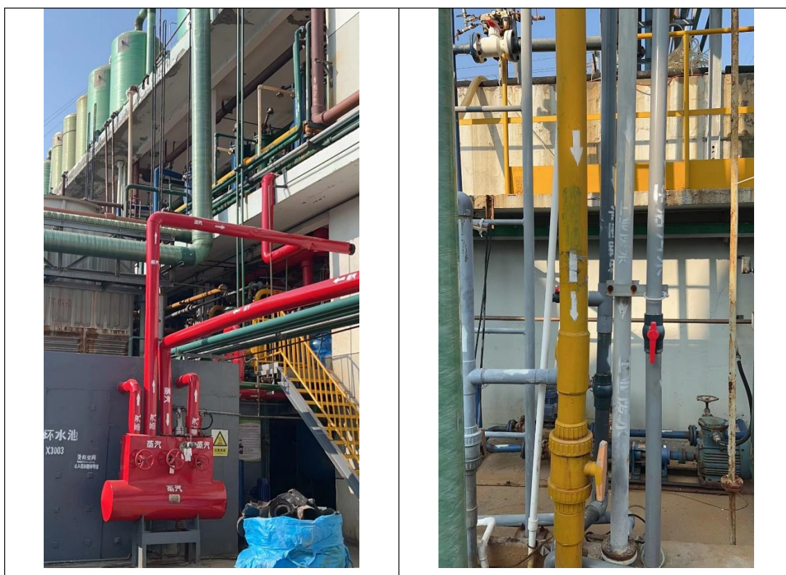
图 4.1-4 物料及污水管线现场排查照片
