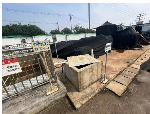
图 4.1-10 应急事故池现场排查照片
