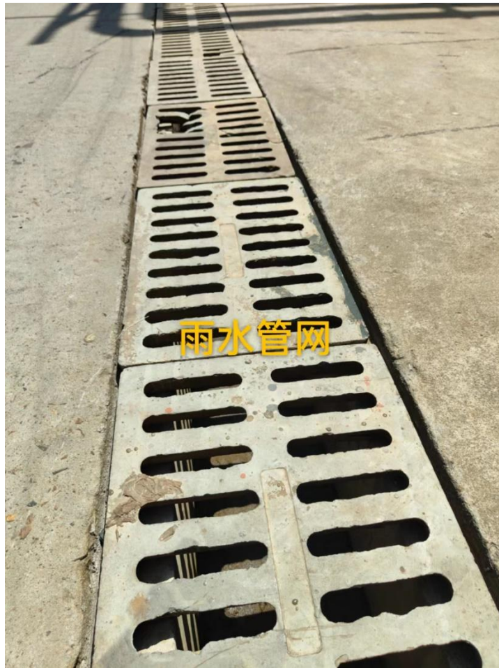
图 4.1-5 雨水管线现场排查照片
