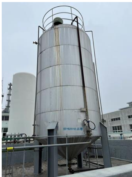
图 5.1-3 离地储罐（频哪酮储罐）现场排查照片
