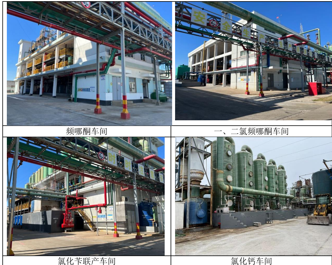
图 5.1-8 生产区现场排查照片
