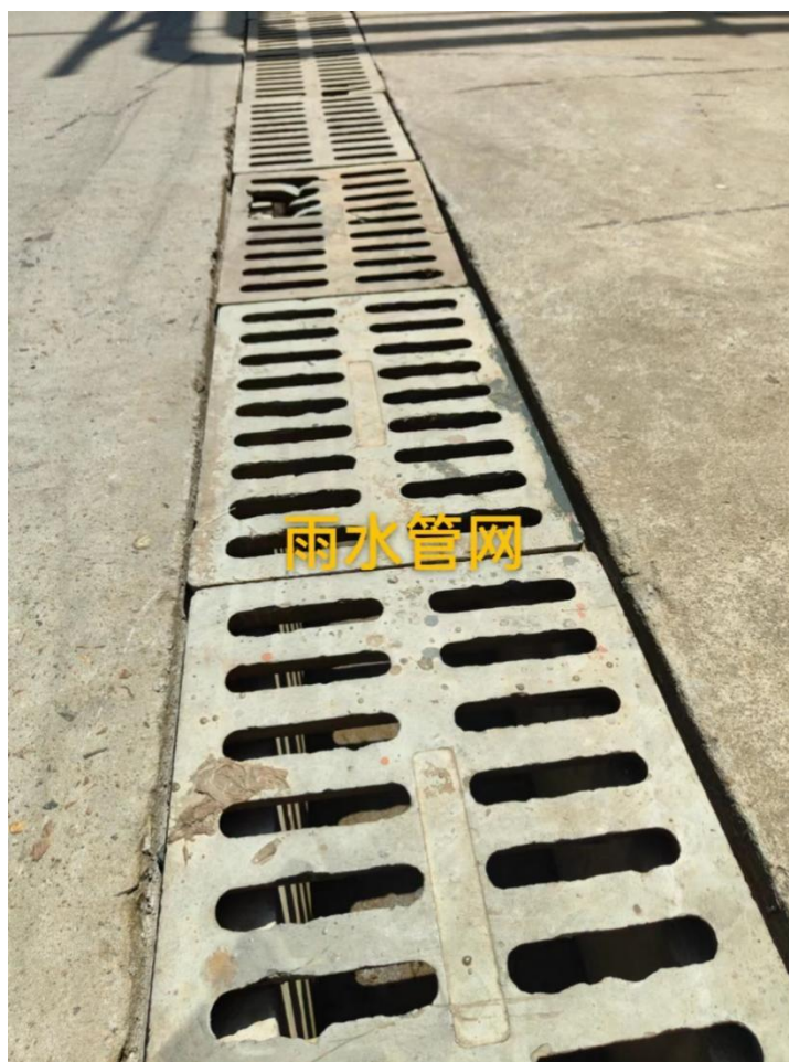
图 5.1-5 雨水管线现场排查照片
