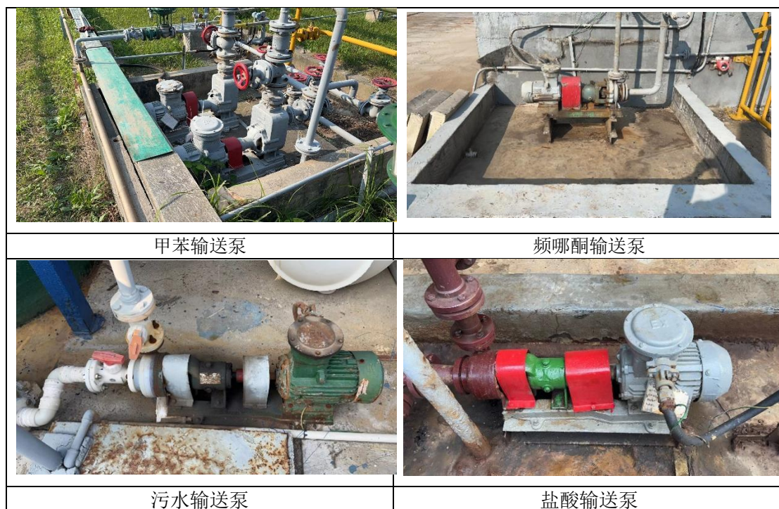
图 5.1-6 传输泵现场排查照片
