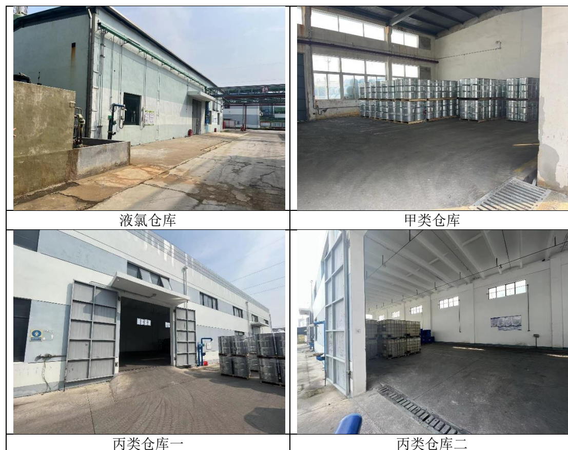
图 5.1-7 货物的储存现场排查照片
