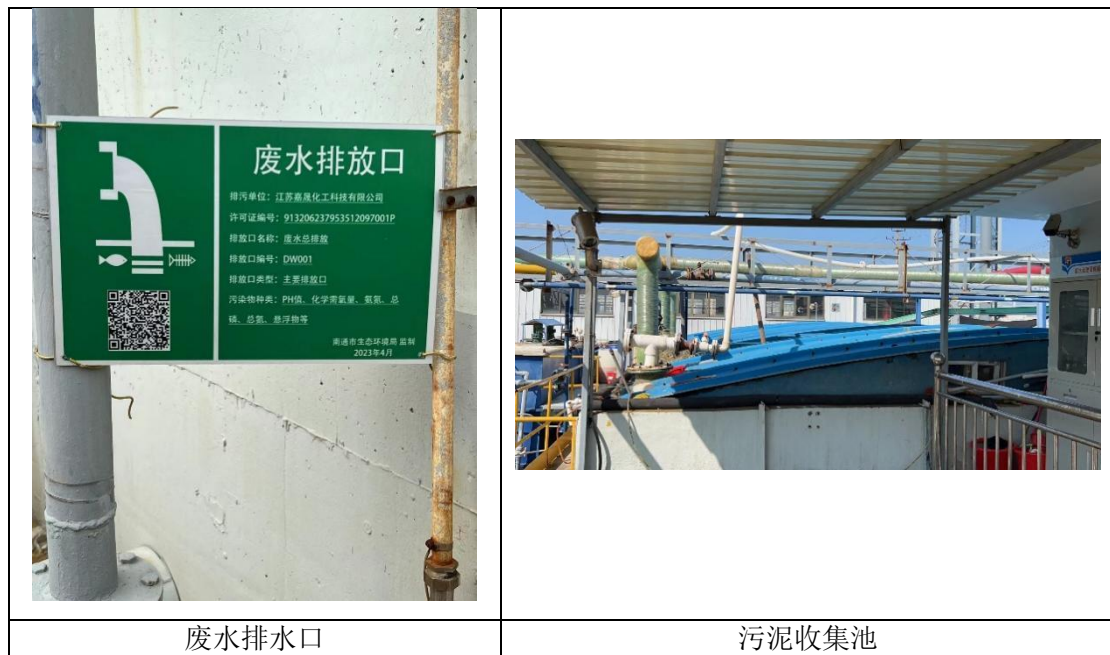
图 5.1-9 废水排水系统现场排查照片
