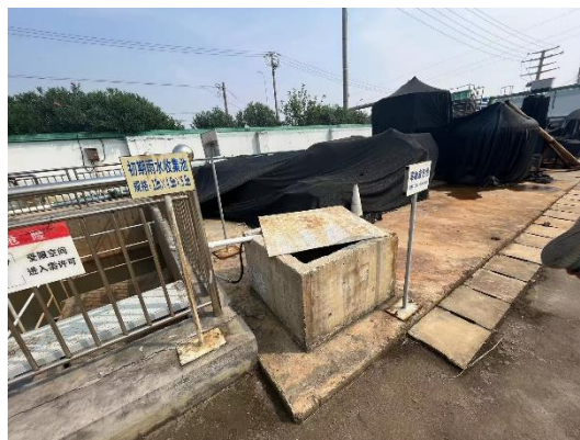
图 5.1-10 应急事故池现场排查照片
