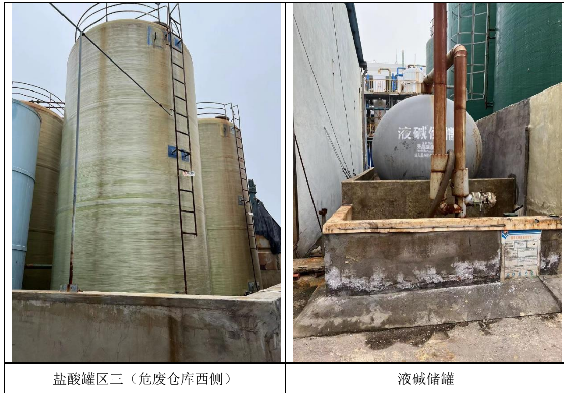
图 5.1-2 接地储罐现场排查照片
