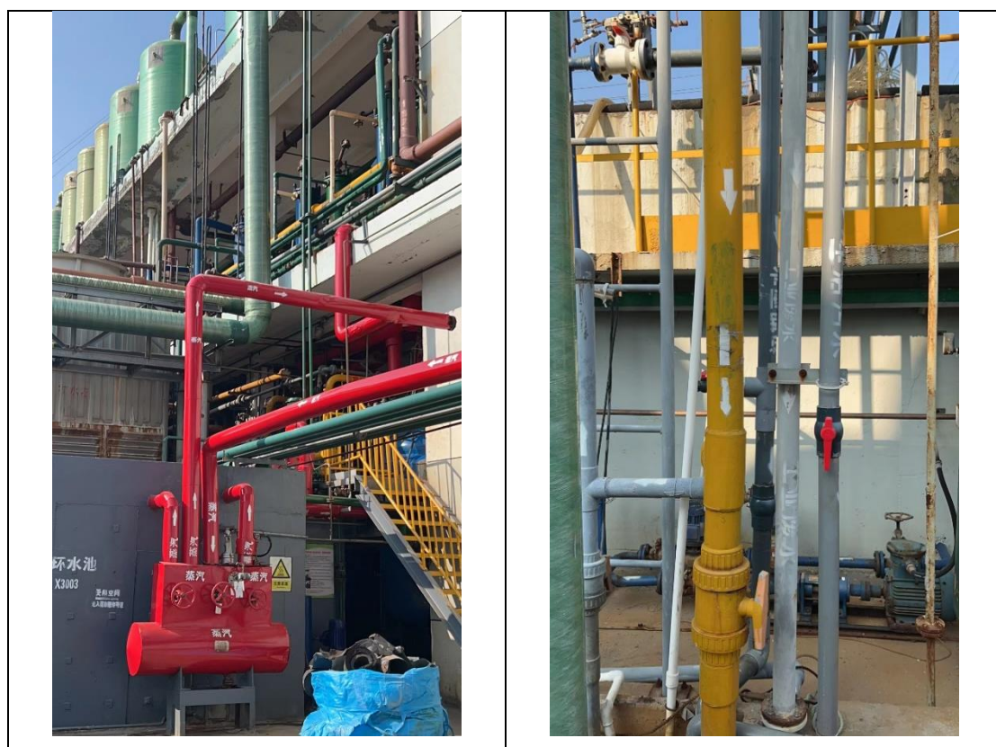
图 5.1-4 物料及污水管线现场排查照片
