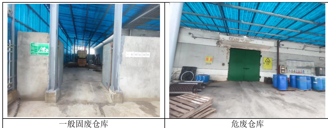
图 5.1-14 危废仓库现场排查照片
